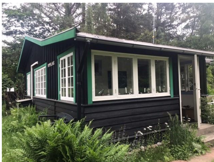
Eksempel på træhus fra 1930erne, med de karakteristiske vindskeder og vinduesrammer i klare farver.
